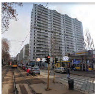
Palazzo INA in Corso Sempione a Milano Arch. Piero Bottoni
